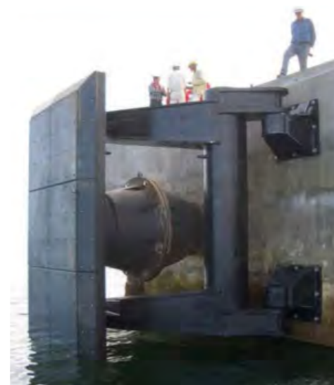
Aplicación de PE-500 y PE-1000 en Defensas Polystone®
