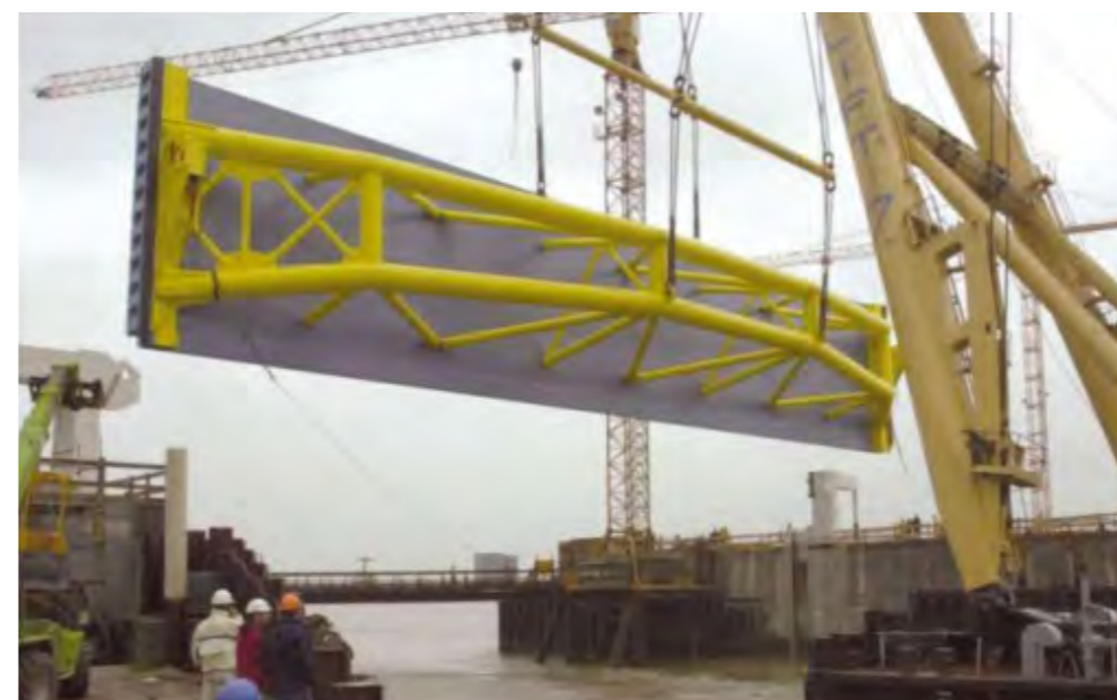
Aplicación de PE-500 y PE-1000 en Guías para escudos Polystone® Mslide
